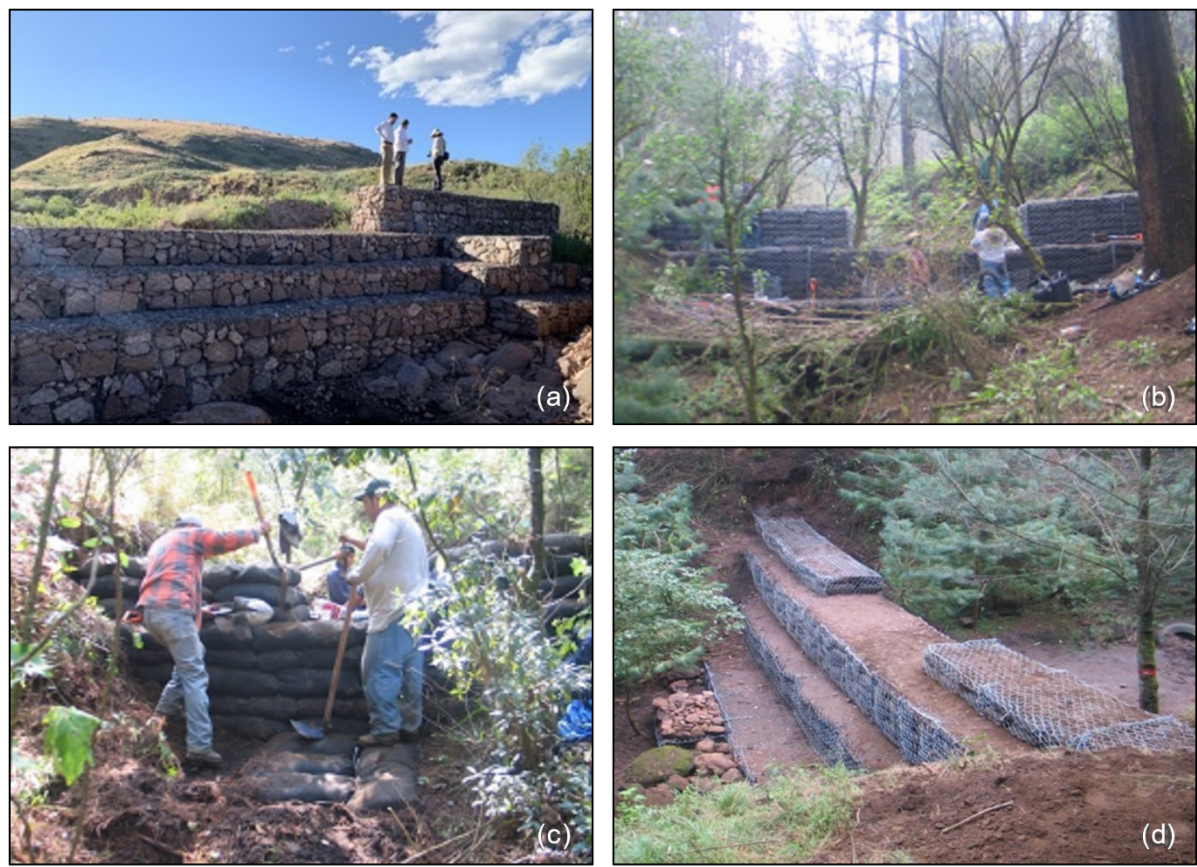
Figura 6.12. Presas de geo-costales en la cuenca alta del río Magdalena (a, b, c) y presas filtrantes de gaviones rellenas de geo-costales (d)
