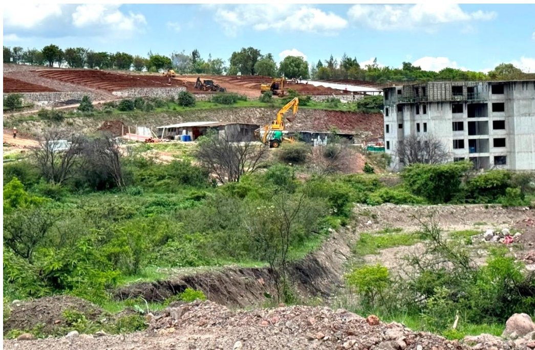
Foto II. 1.- Infraestructura temporal existente en el Área de influencia
